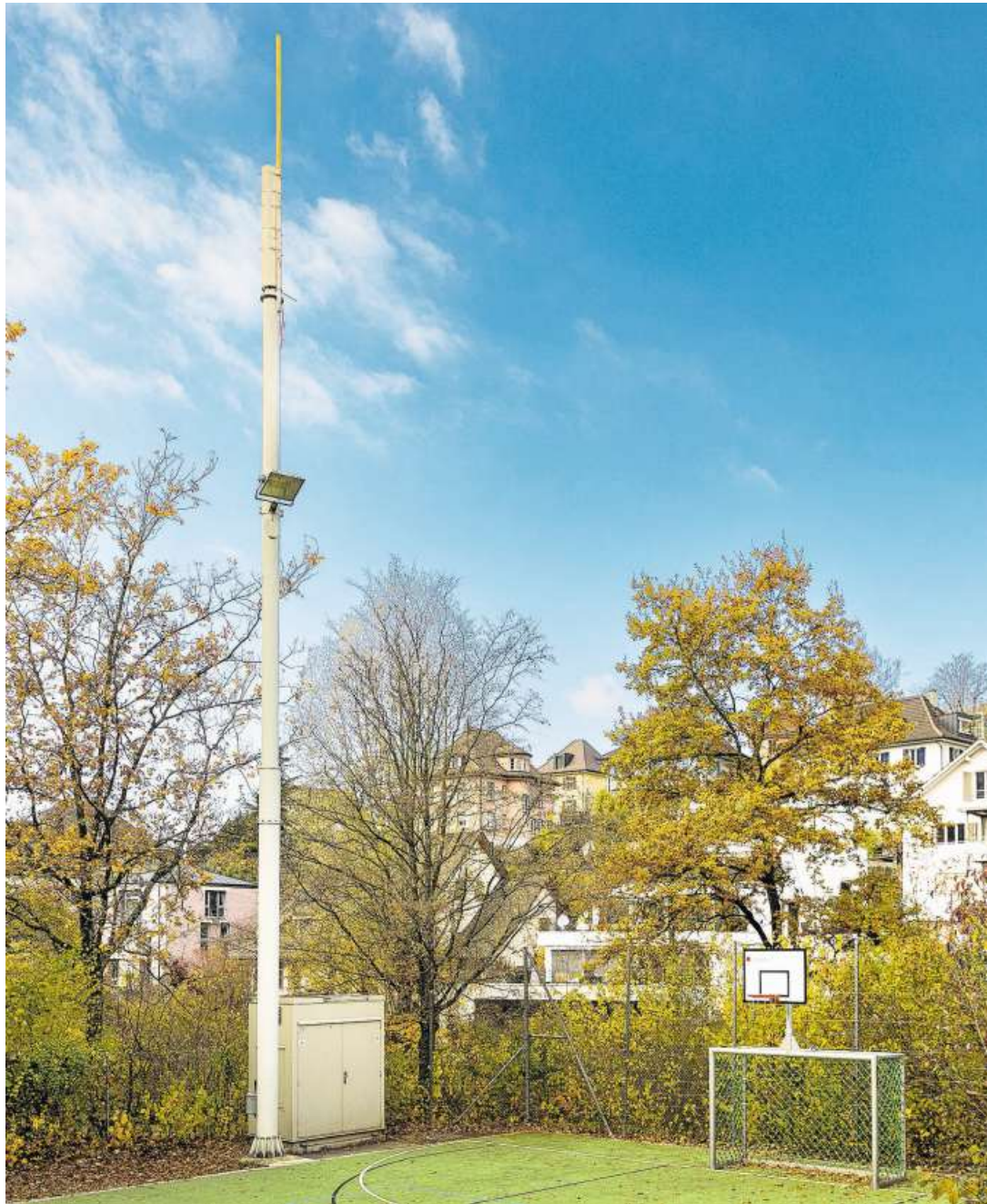
Die Swisscom will den Mobilfunkantennenmast um 2,5 Meter erhöhen.
